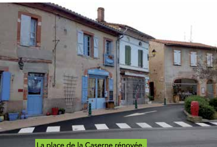
La place de la Caserne rénovée.
