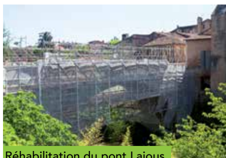
Réhabilitation du pont Lajous.
